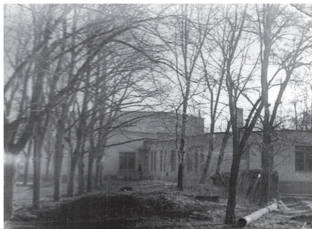
Строительство здания под ускоритель
